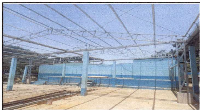
Foto 3: Sustitucion de elementos de fijacion
