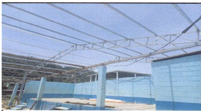
Foto 4: Sustrucion de bajada de agua pluvial de metal por tubo PVC 3"
