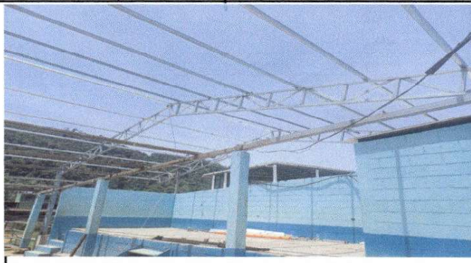
Foto 2: Sustrucion de estructura de soporte de metal por metal
