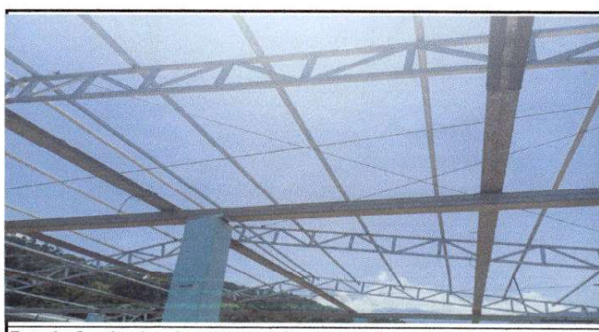
Foto 6: Sustrucion de estructura de soporte de metal, por metal
